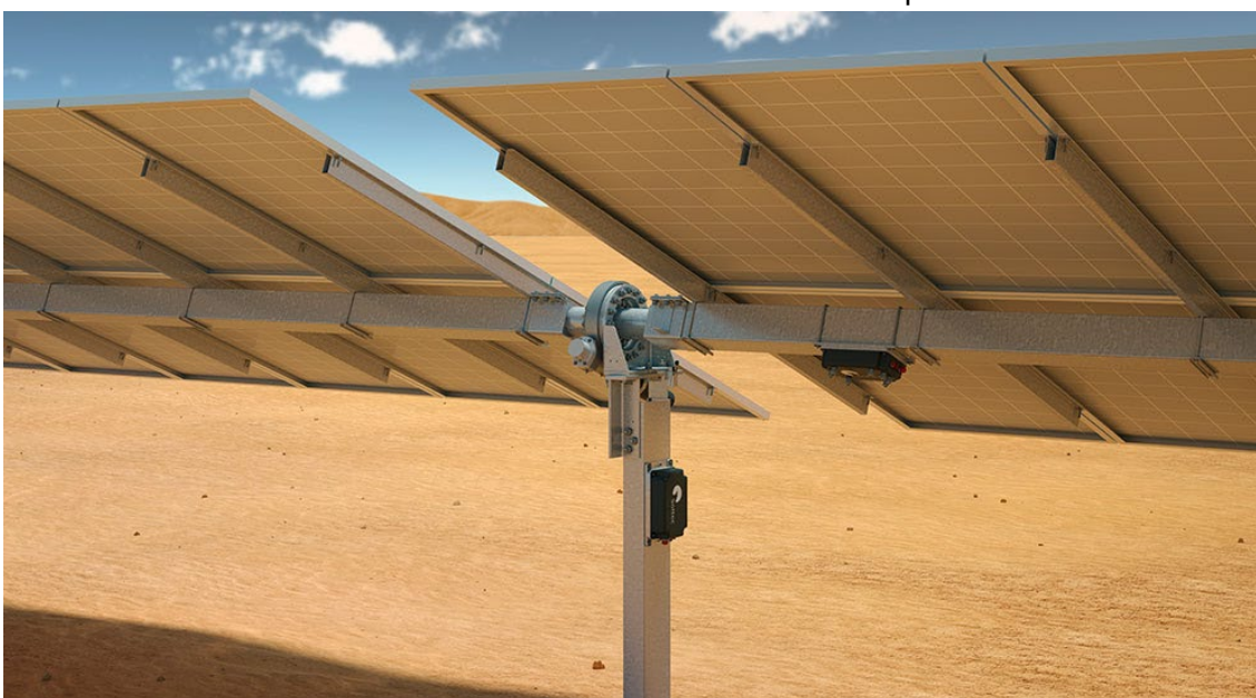
Figura 2: Tipico tracker ad inseguimento monoassiale (inseguitori di rollio) con modulo fotovoltaico monofacciale e/o bifacciale con doppio vetro trasparente
