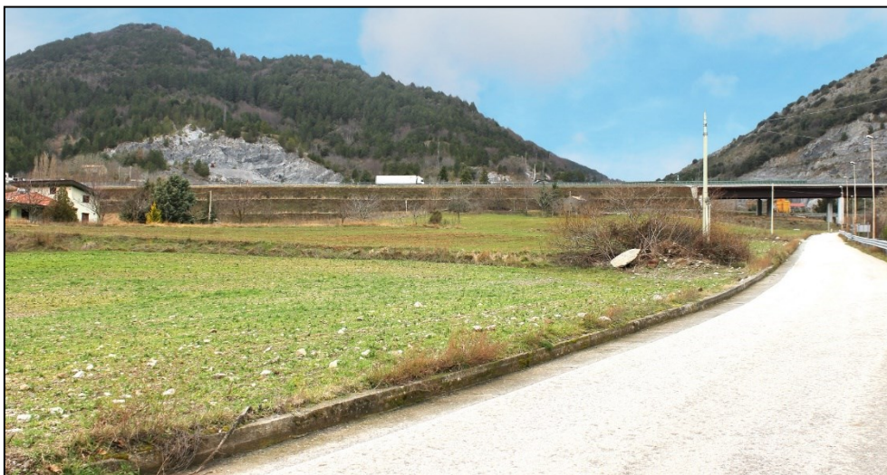
Figura 28 - L'area di intervento della rampa 2-2 di uscita dalla carreggiata sud- Stato Ante operam
