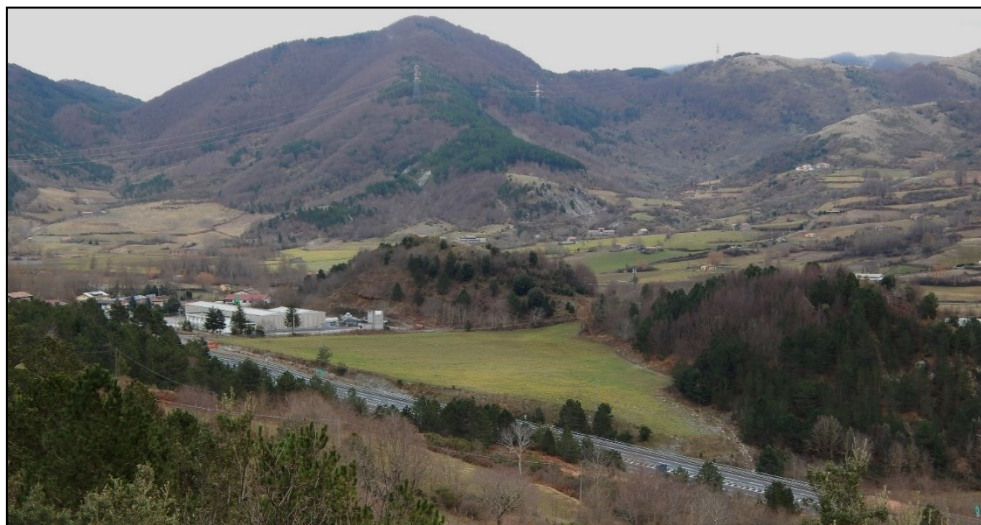
Figura 25 - L'area di intervento della rampa 2-2 di ingresso alla carreggiata sud- Stato Ante operam
