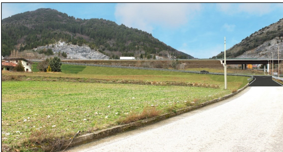
Figura 29 - Stato post operam
