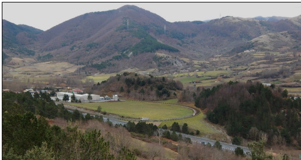
Figura 26 - Stato post operam
