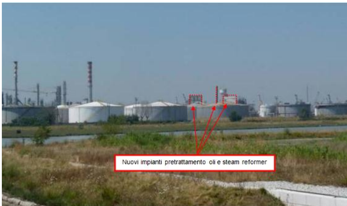
Figura 40. Nuovi impianti presso Raffineria di Venezia (punto di vista n. 6 dal ponte della Libertà)
