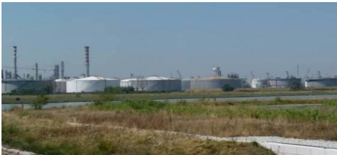
Figura 38. Inserimento paesaggistico Raffineria di Venezia scenario attuale (punto di vista n. 6 dal ponte della Libertà)
