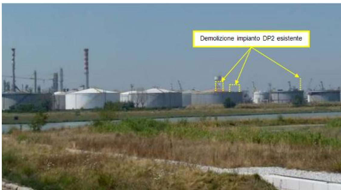
Figura 39. Demolizioni impianti presso Raffineria di Venezia (punto di vista n. 6 dal ponte della Libertà)
