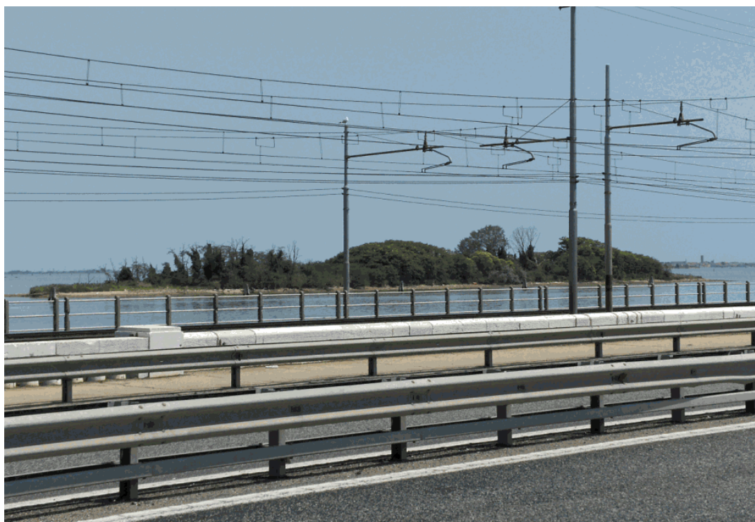
Figura 33. Sistema viario e ferroviario del Ponte della Libertà.
