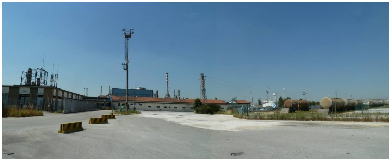
Figura 5. Raffineria di Venezia scenario attuale (punto di vista n. 5 da via dei Petroli)
