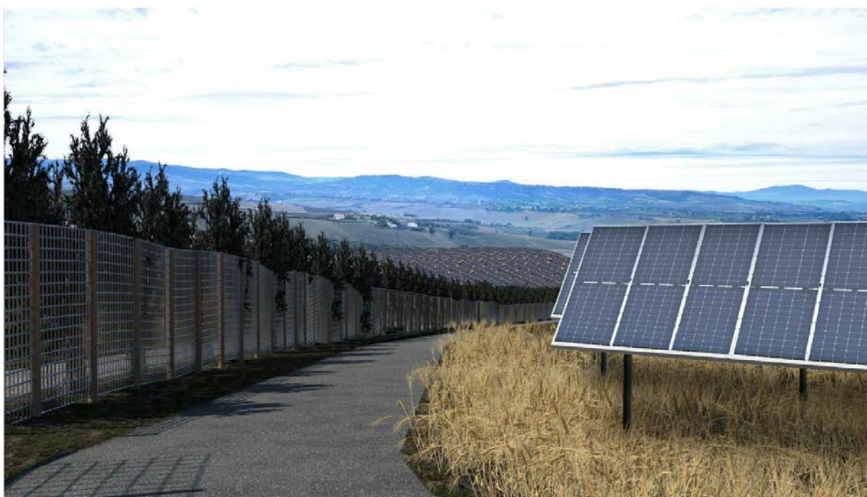
Figura 29: Foto 1-vista post operam, sulla destra è possibile osservare i moduli di tipo tracker mono-assiale e le piantagioni a grano. A sinistra la strada interna al campo con recinzione e alberi di ulivo, oltre i quali vi è la pista ciclo-pedonale
