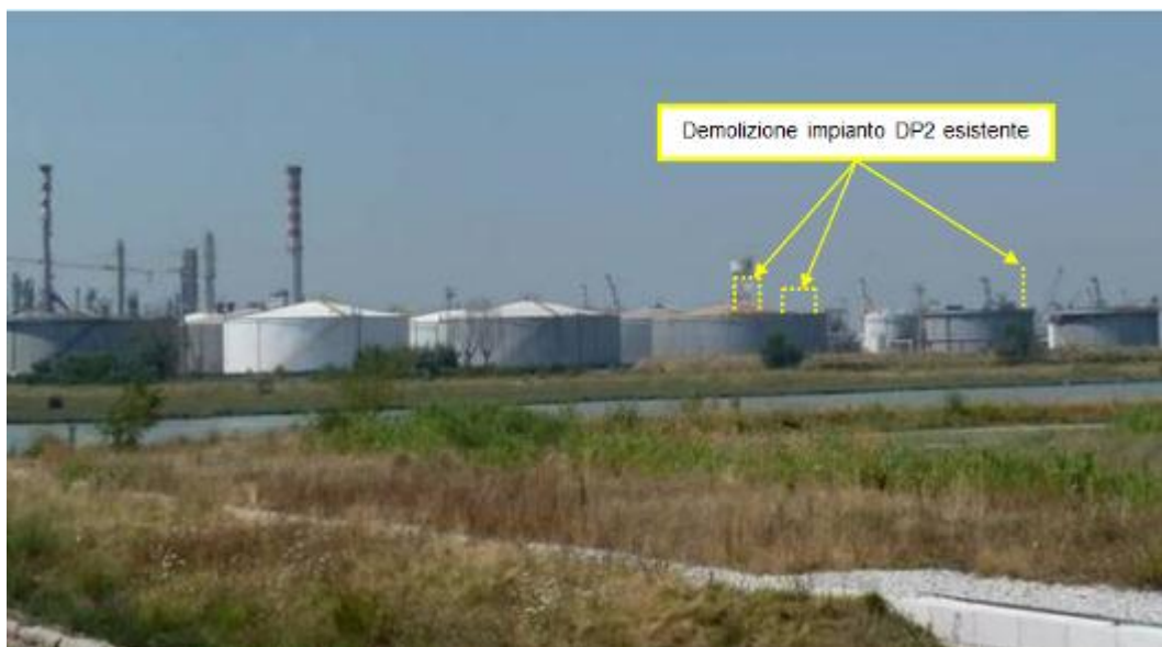
Figura 24. Demolizioni impianti presso Raffineria di Venezia (punto di vista n. 6 dal ponte della Libertà)
