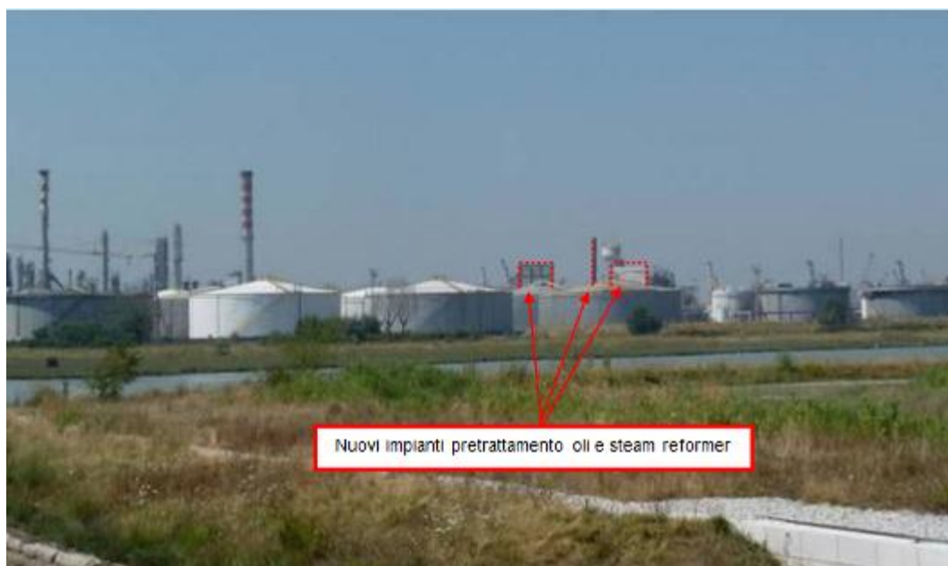
Figura 25. Nuovi impianti presso Raffineria di Venezia (punto di vista n. 6 dal ponte della Libertà)
