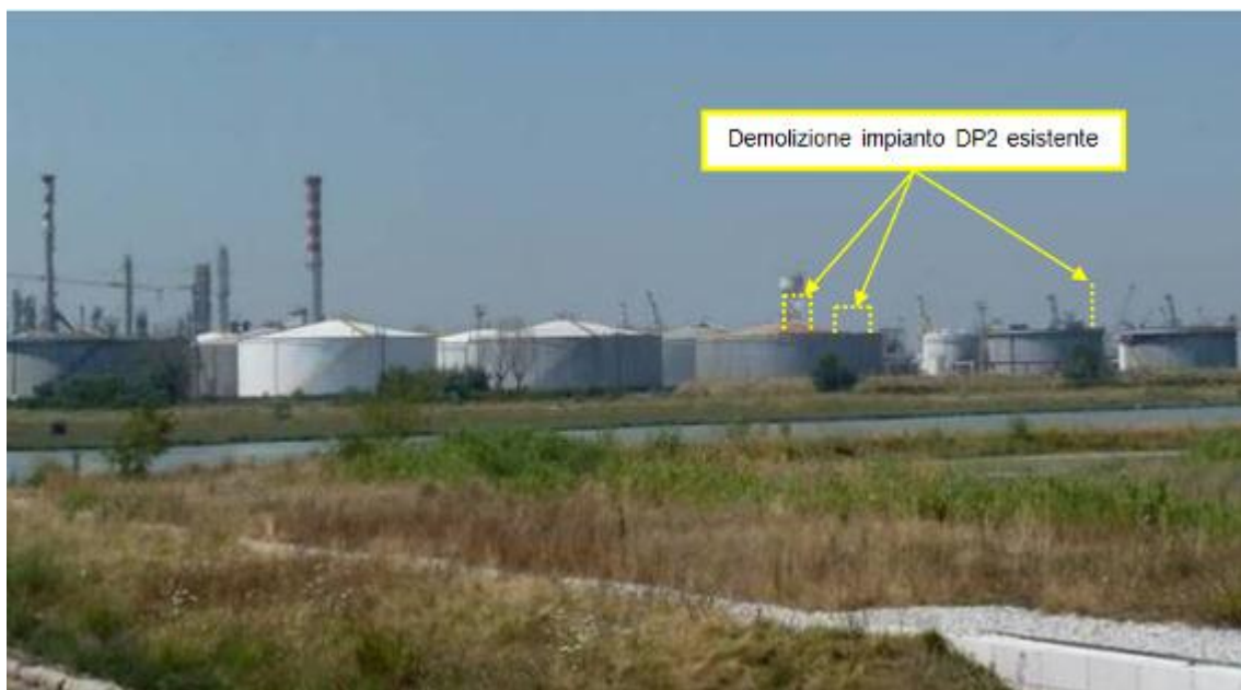
Figura 5. Demolizioni impianti presso Raffineria di Venezia (punto di vista n. 6 dal ponte della Libertà)
