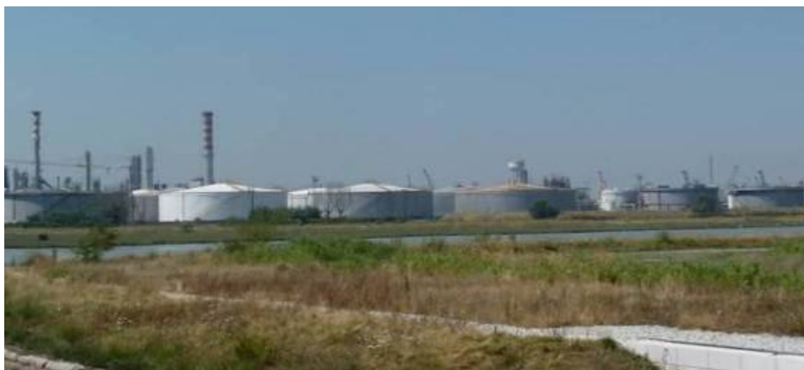
Figura 4. Inserimento paesaggistico Raffineria di Venezia scenario attuale (punto di vista n. 6 dal ponte della Libertà)
