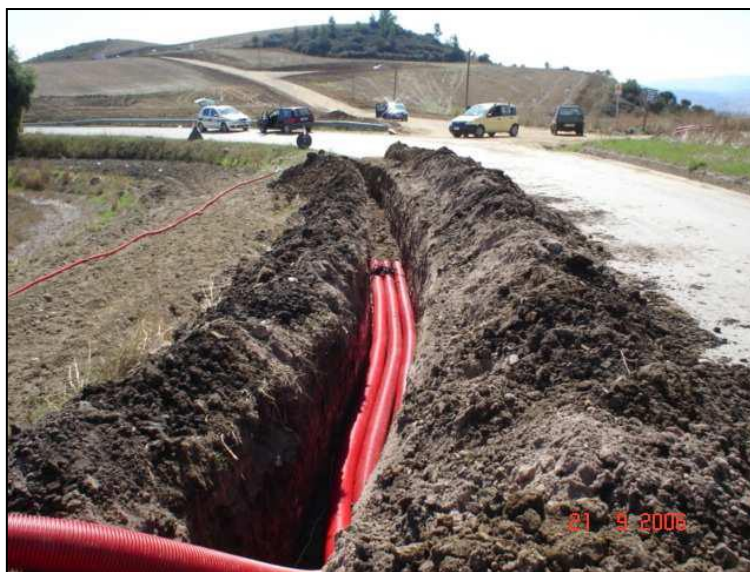
Fig. 1.1: Foto illustrativa della messa in posa dei cavidotti MT
