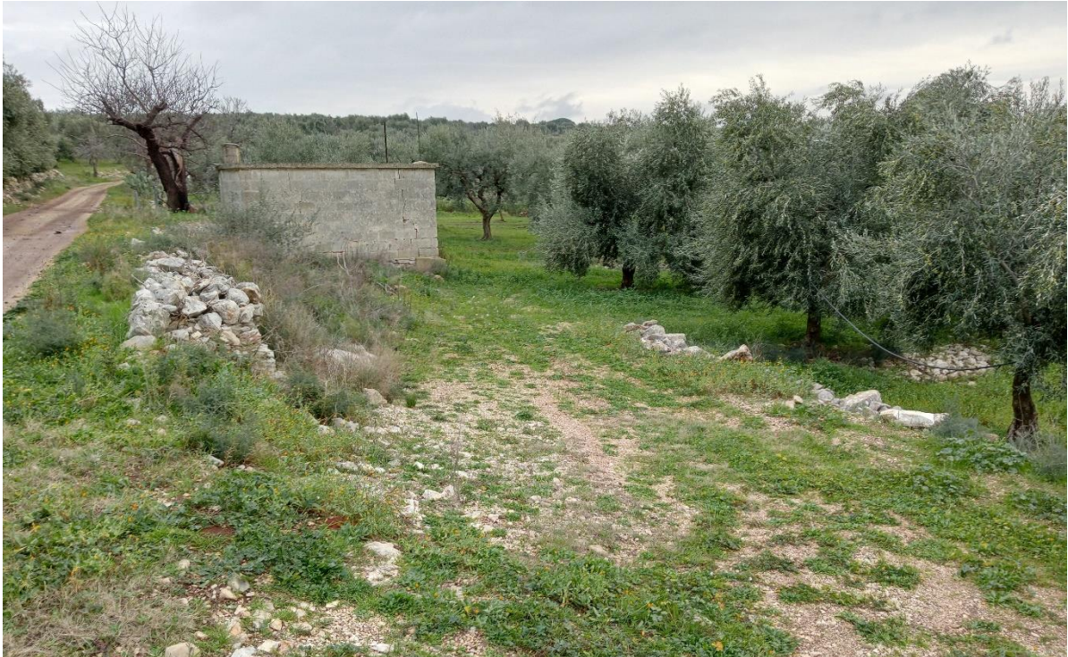
Foto 3 Lama Ferratella nell'area di intersezione del cavidotto MT interrato lungo tracciato stradale (a sinistra)
