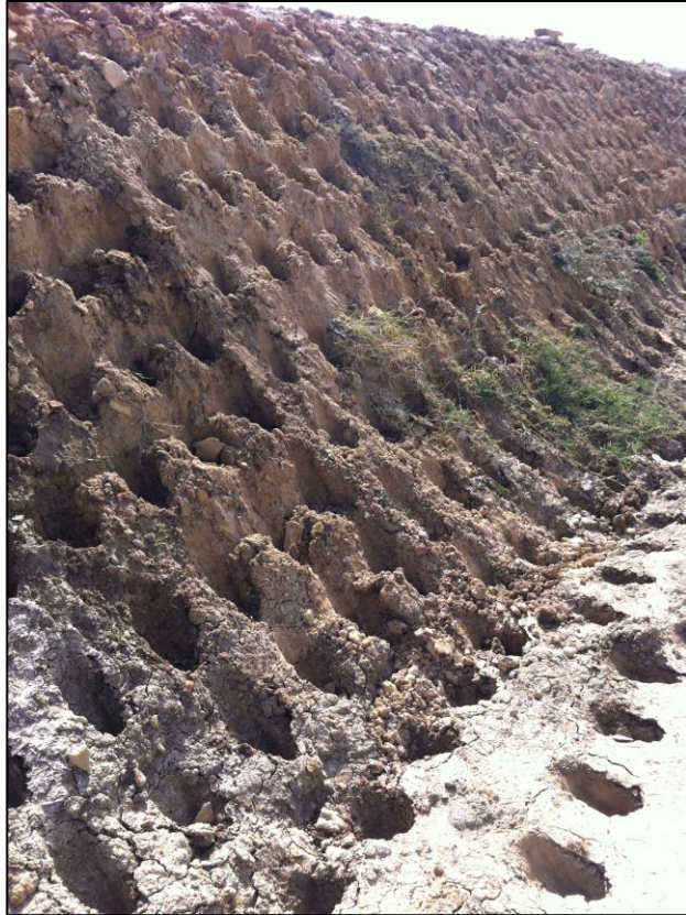
Preparazione della scarpata bordo strada per la Idrosemina
