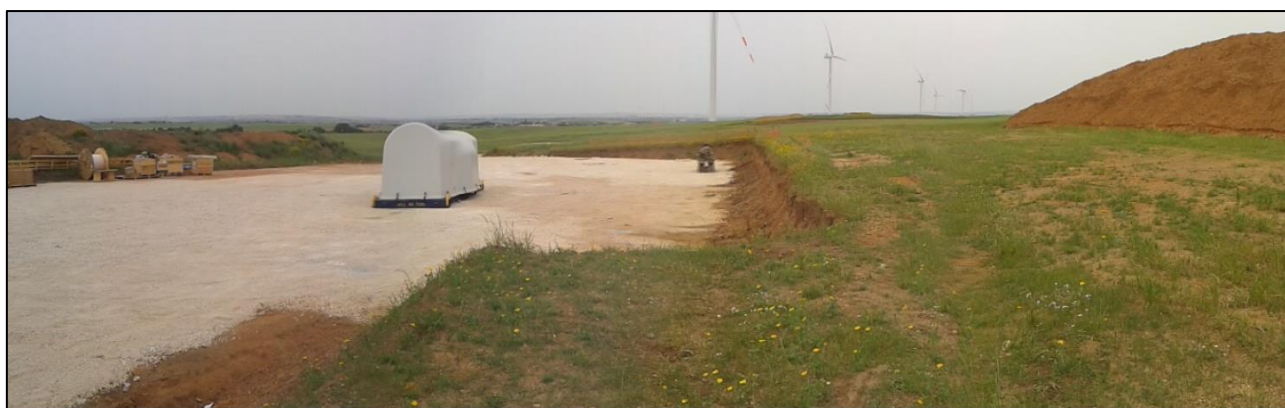
Piazzola di Cantiere (a sinistra) e Piazzola stoccaggio Pale (a Destra)
