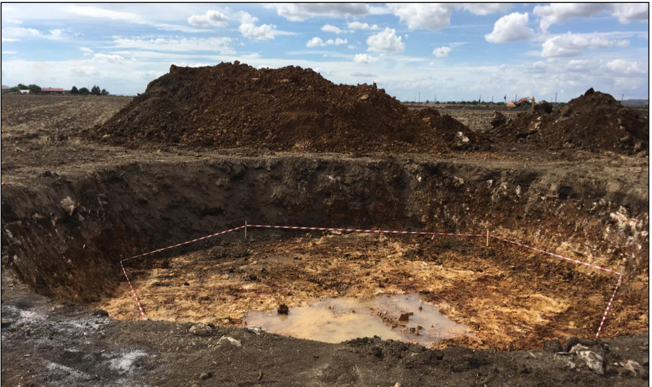
Scavo Fondazione Plinto Aerogeneratore
