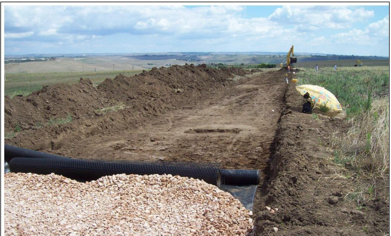
Viabilità di nuova realizzazione – Fase di scavo superficiale (scotico) con inizio di posa di massicciata e geogriglia
