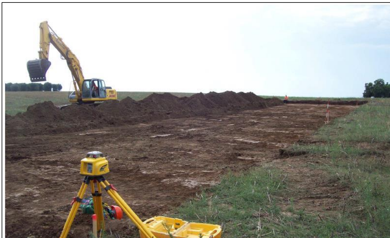
Scavo di sbancamento per la realizzazione di una nuova piazzola
