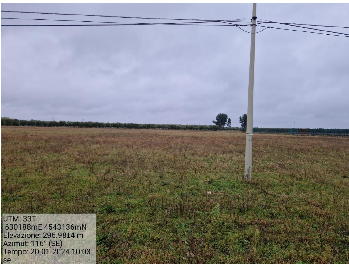
Figura 19. Stazione Elettrica Utente (rilievo del 20 gennaio 2024)
