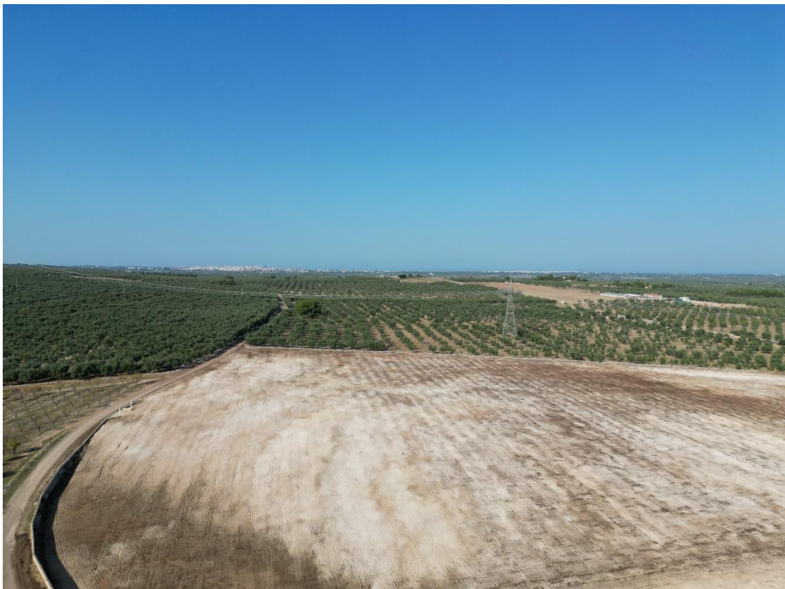
Figura 7. WTG8 vista dall'alto (rilievo del 29 settembre 2023)
