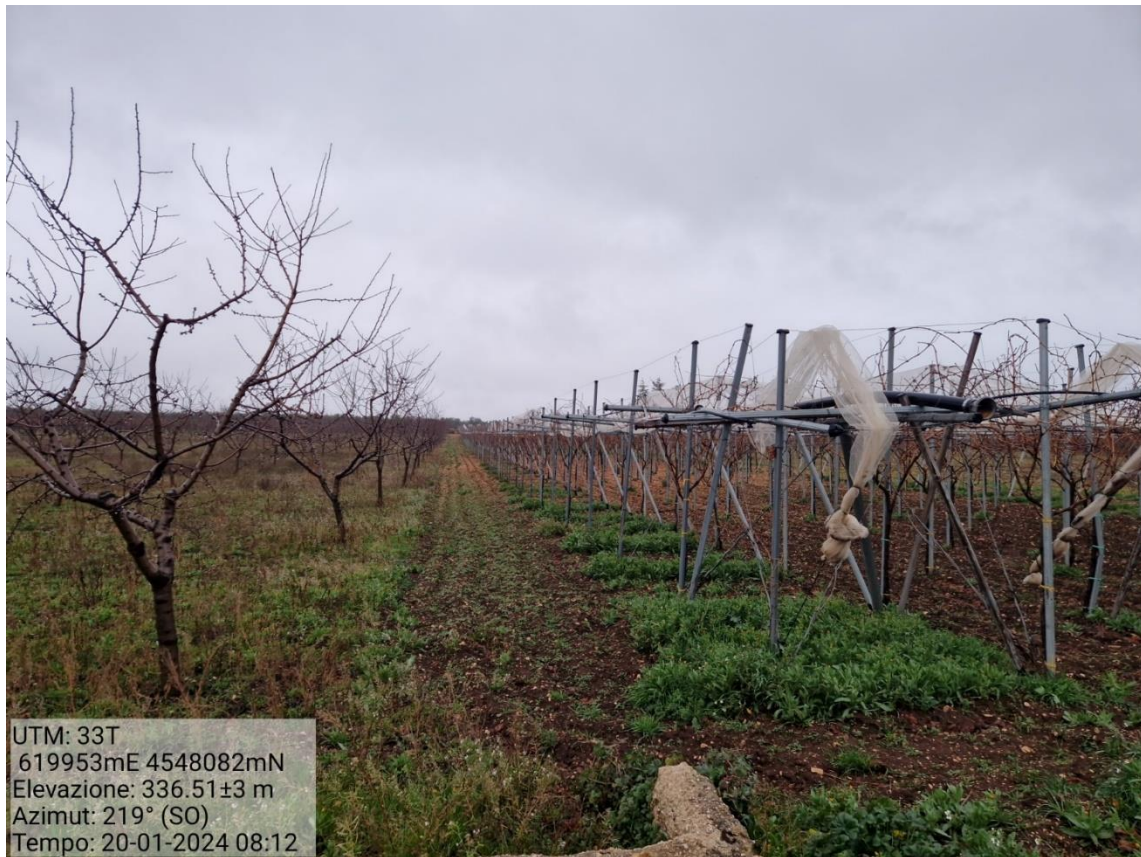
Figura 12. Immediato intorno WTG2 (rilievo del 20 gennaio 2024)
