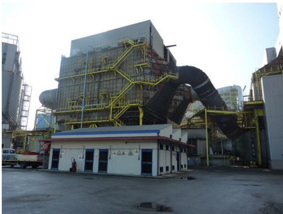
Figura 3 - Precipitatore elettrostatico unità 1
