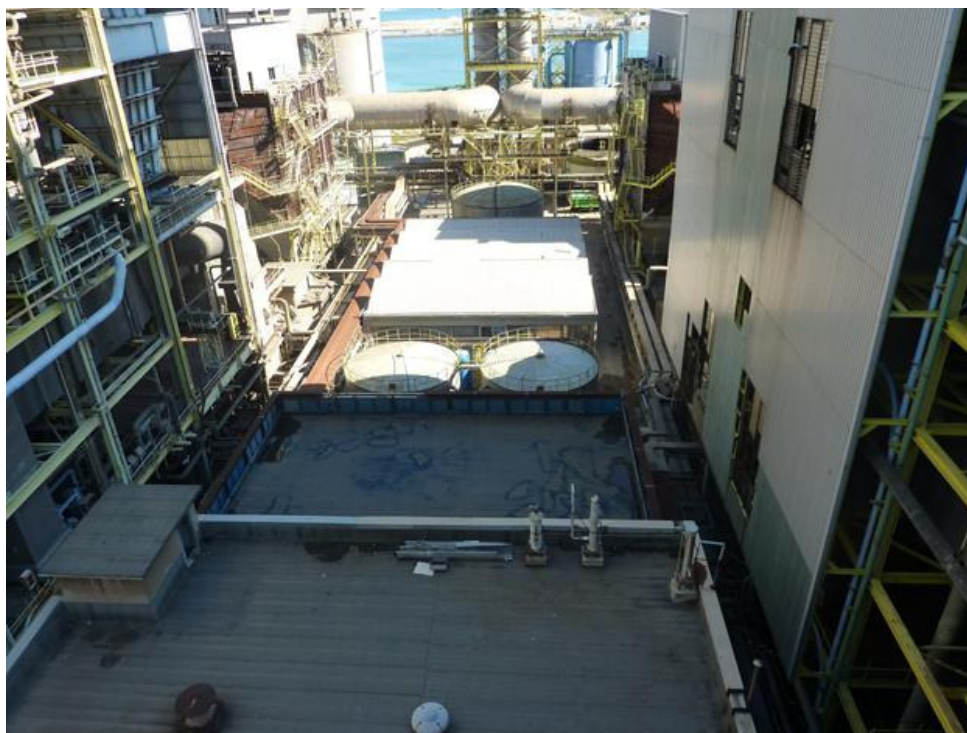
Figura 5 - Area intermedia tra le due caldaie oggetto di demolizione
