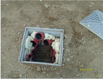
Accertando la compatibilità con le relative norme di utilizzo o di installazione, i pozzetti possono essere impiegati come rompitratta, collocati in corrispondenza dei punti luminosi per l'alloggiamento di opportune morsettiere, come pozzetto di derivazione o cambiamento di direzione.
