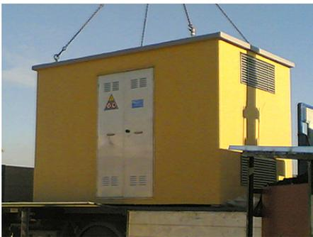
Tutte le cabine sono realizzate in conformità alla normativa vigente sui manufatti in calcestruzzo armato vibrato: Legge 1086/71 - D.M. 3/12/87 - circolare n. 31104 del 16/03/89. I progetti sono depositati al Min. LLPP. I manufatti sono inoltre conformi alle norme CEI 11-1 e CEI EN 61330.
