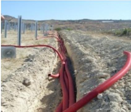
*Figura 5: Tipo Cavidotto interrato*
