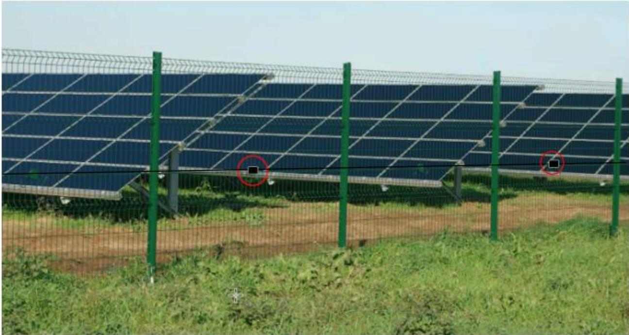
Figura 11: tipologico della recinzione con indicazione dei sensori antintrusione
