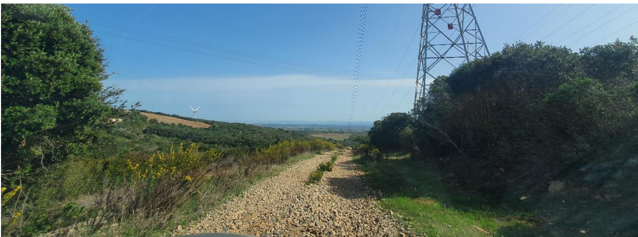
FIGURA 3 – FOTO DELLA STRADA INTERESSATA DAL PASSAGGIO DEL CAVIDOTTO NELL'AREA GRAVATA DA USO CIVICO
