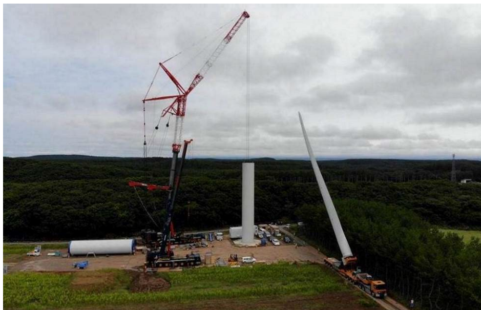
Figura 15 – Fasi di montaggio dell'aerogeneratore.
