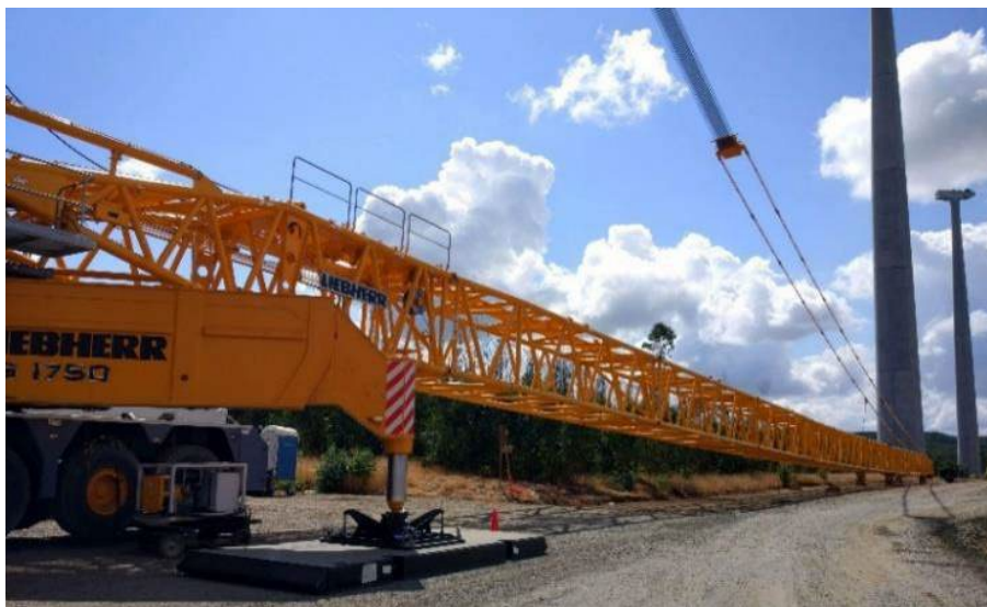
Figura 14 – Fasi di montaggio della gru principale.
