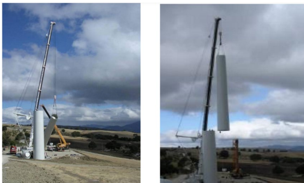
Figura 26 – Fasi di montaggio della torre dell'aerogeneratore.
