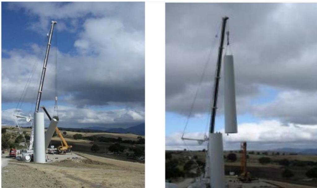
*Figura 2 – Fasi di montaggio della torre dell'aerogeneratore.*
