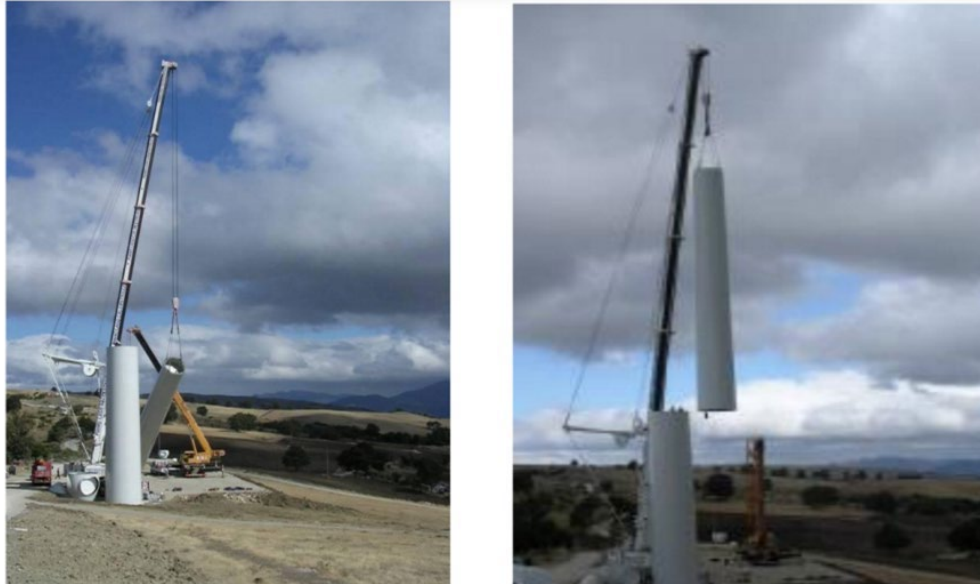
Figura 26 – Fasi di montaggio della torre dell'aerogeneratore.
