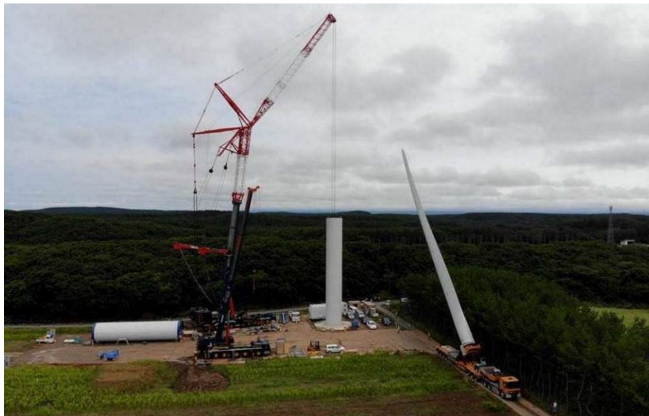
Figura 15 – Fasi di montaggio dell'aerogeneratore.
