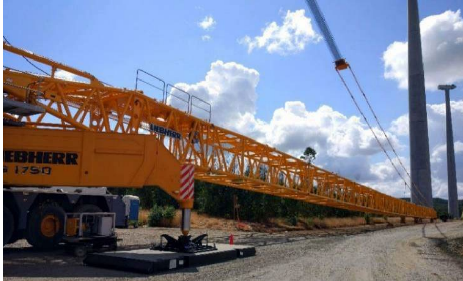
Figura 14 – Fasi di montaggio della gru principale.
