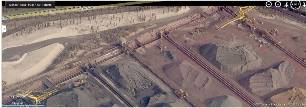
Vista zona uscita materiali dai parchi lato nord
