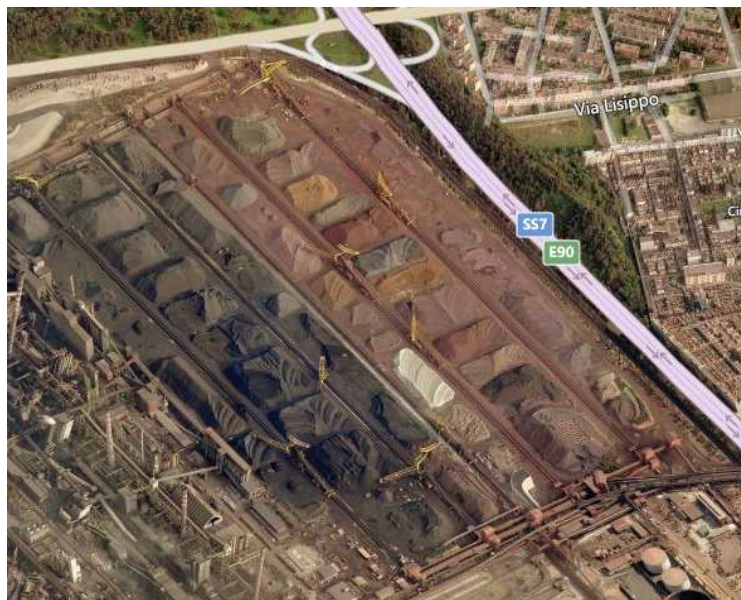
Vista panoramica dei parchi esistenti da coprire
