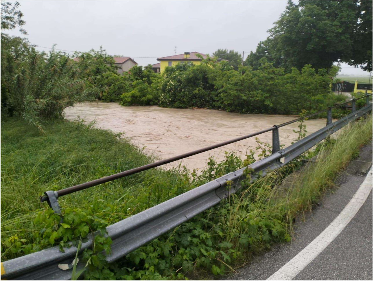
Fig 3 - 17 maggio 2023 – torrente Quaderna, altezza del ponte sulla SP48 (altezza di via Fornace)
