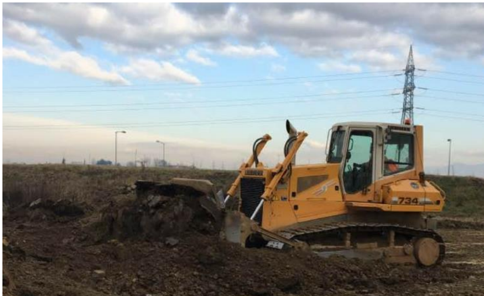
Figura 3- Esempio Attività di Scavo Materiale
