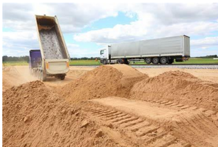
Figura 5- Esempio Attività di Formazione Cumuli di Stoccaggio
