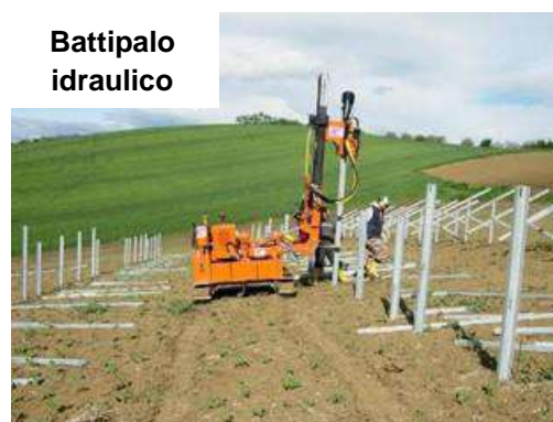
Figura 6-1 – Esempio di posa delle strutture portanti.
