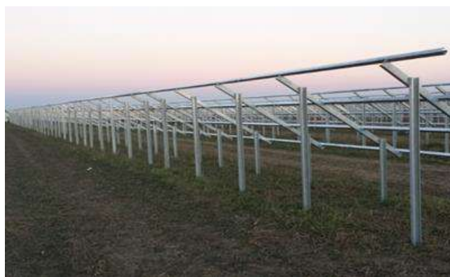
Figura 3-12 - Stato cantiere al termine della fase lavorativa
