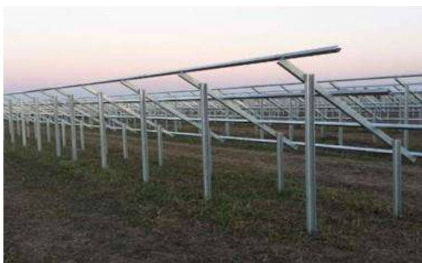
Figura 6-1 – Esempio di posa delle strutture portanti.
