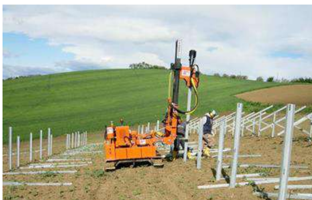
Figura 3-11 – Messa in opera delle strutture di sostegno
