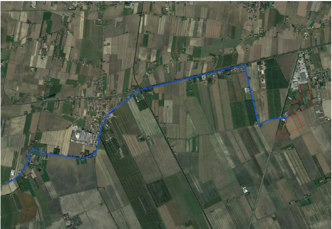
Figura 1-3 – Dettaglio foto aerea dell'area recintata del campo fotovoltaico (tratto rosso) e dell'elettrodotto (tratto blu)
