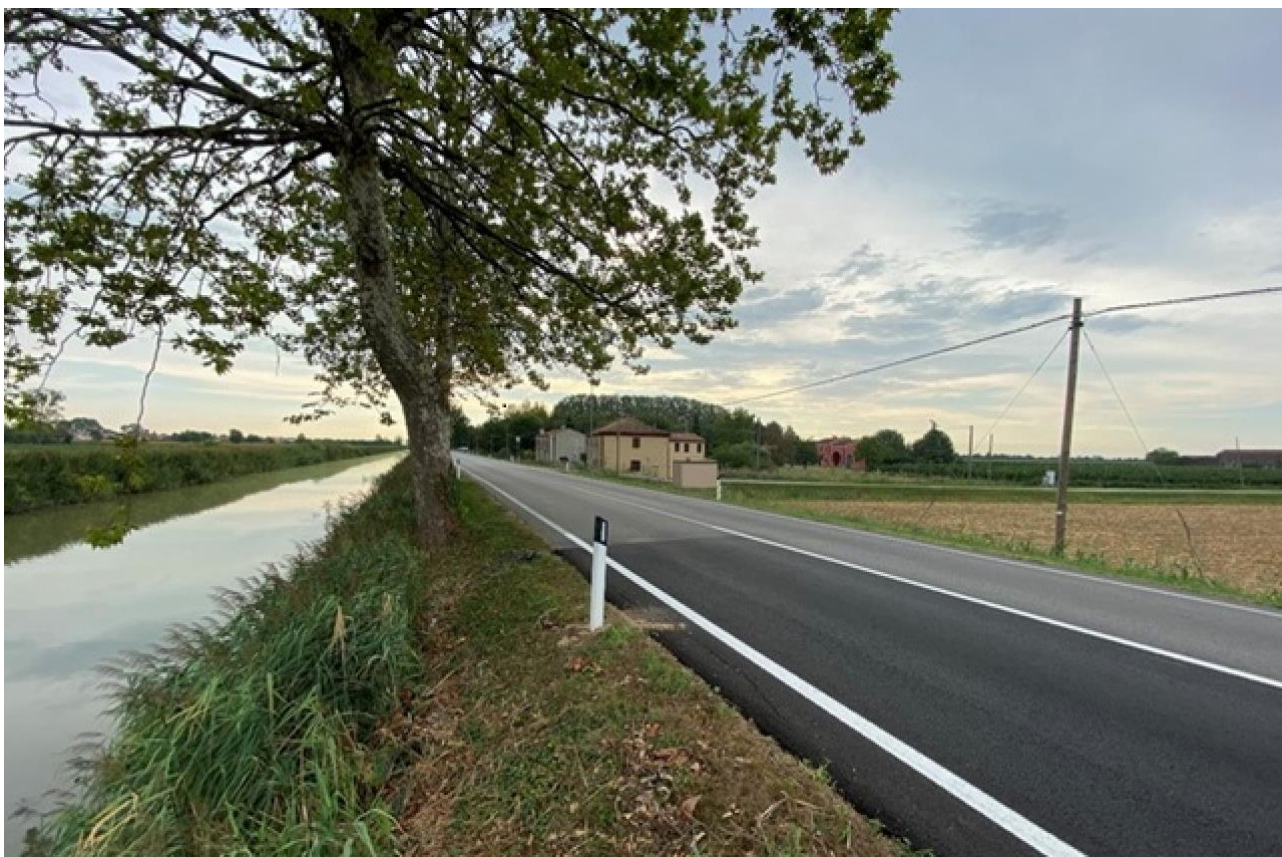
Figura 6-2 –Cabina Corte Rezzonica - Post Operam
