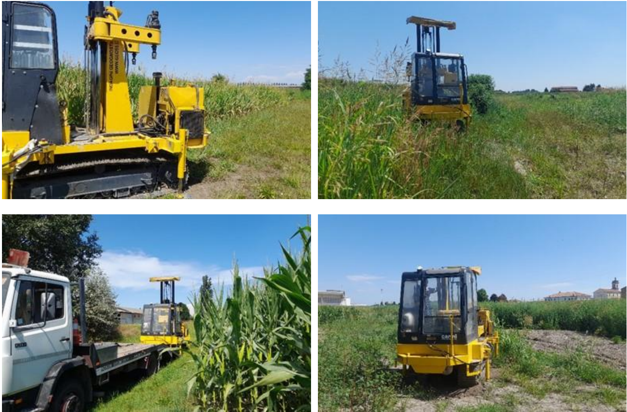
Figura 5-2 - Mezzo utilizzato per le prove CPTe
