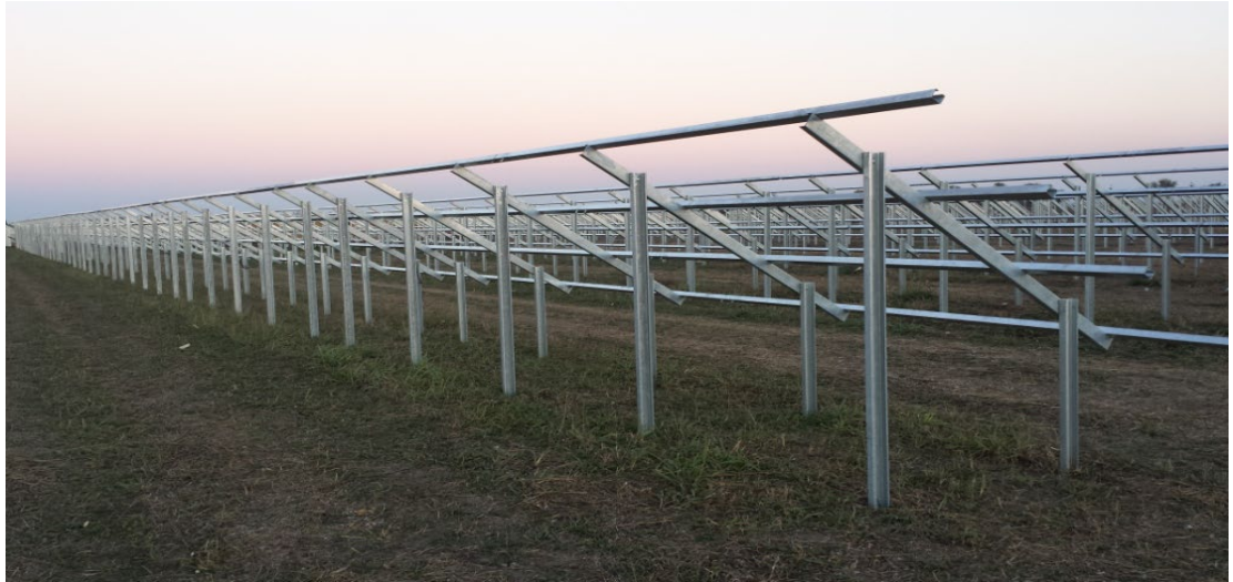
Figura 4: - Stato cantiere al termine della fase lavorativa
