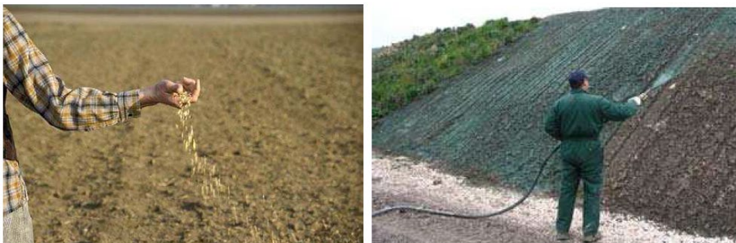
Figura 6- Idrosemina e semina a spaglio
