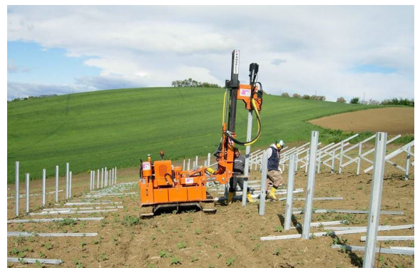
Figura 3 - Posa strutture metalliche di fondazione
