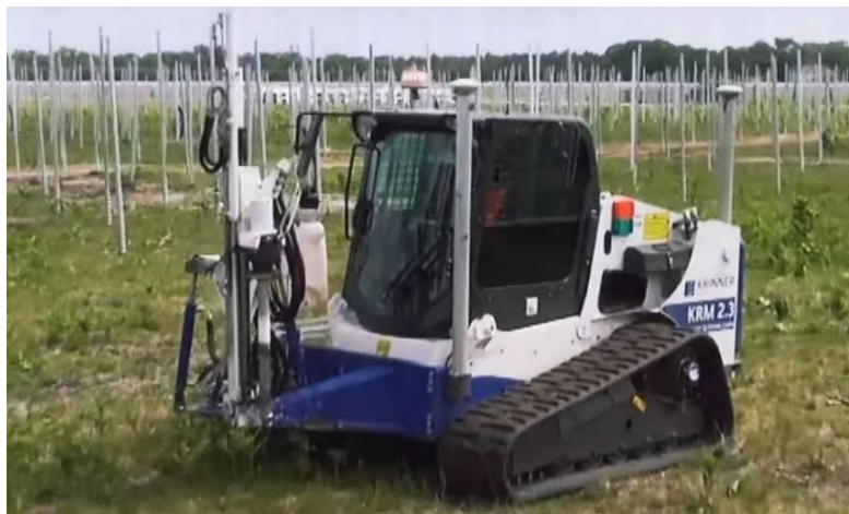
Figura 7 - Esempio di fissaggio delle strutture di supporto
