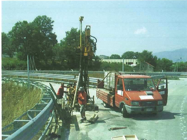
Foto 1: La sonda Beretta "T41" nel corso del sondaggio S1
