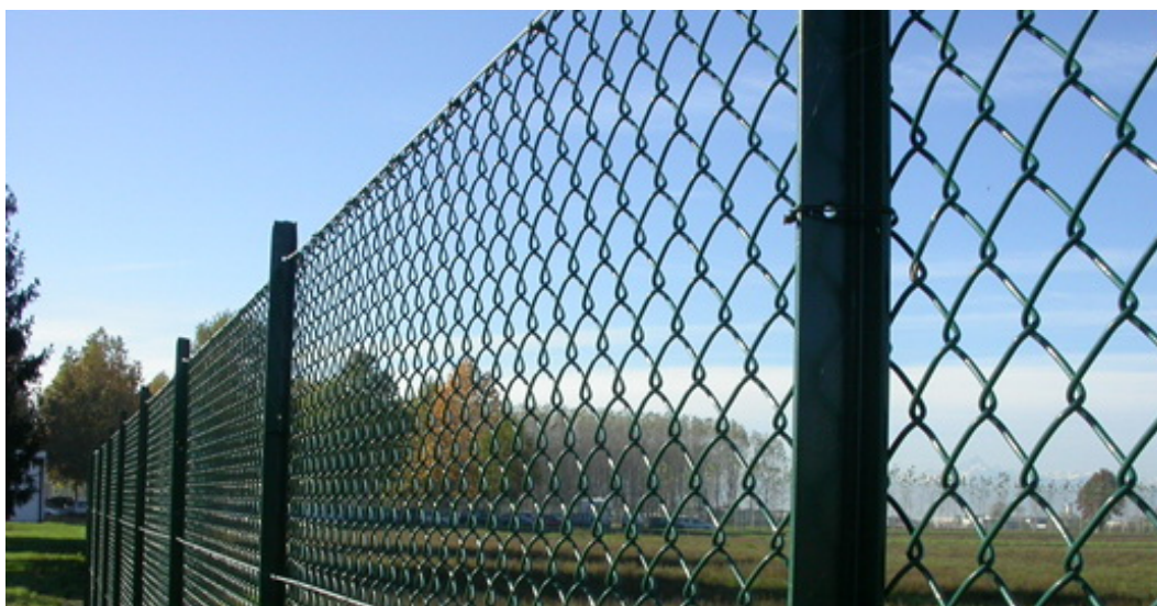
Figura 4. Esempio di recinzione perimetrale con pali ad infissione nel terreno senza utilizzo di plinti in cemento
