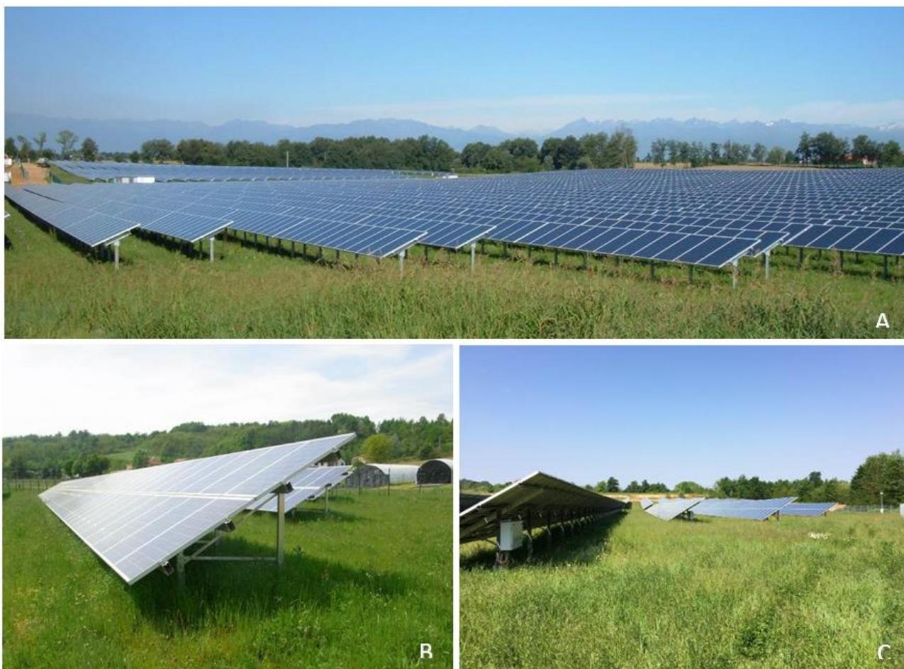
**Figura 92.** Immagini di grandi impianti fotovoltaici a terra (scattate dagli scriventi) riferite a progetti realizzati (anche con tecnologie differenti) che forniscono evidenza oggettiva dell'effetto non limitante dell'ombreggiamento generato per l'attività fotosintetica. A) Impianto FV "Ternavasso" – 7,5 MWp, Poirino (TO); B) Impianto FV "Cortiglione Green" – 0,8 MWp, Cortiglione (AT); C) Impianto FV "Sulpiano Cross" – 2,5 MWp, Montà (CN).
