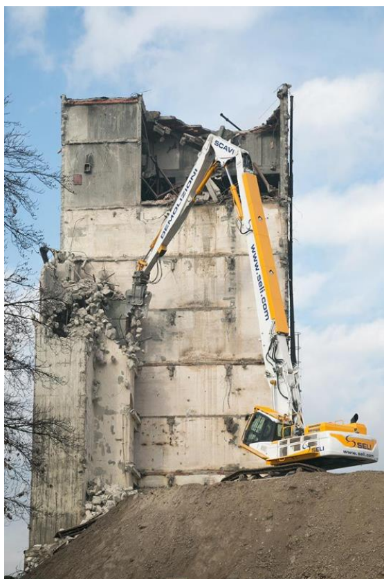
Figura 1 – Esempio escavatore con pinza idraulica
