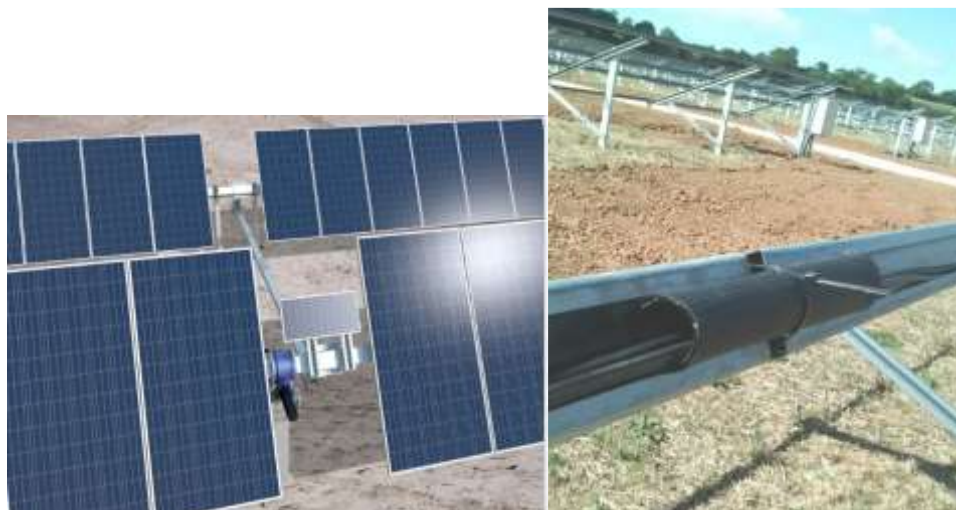
Figura 12 – Cablaggio stringhe
