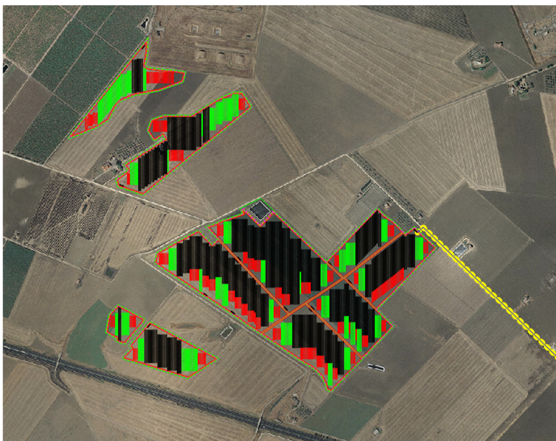
Figura 1-1 Impianto AGROSOLAR 3 su ortofoto
