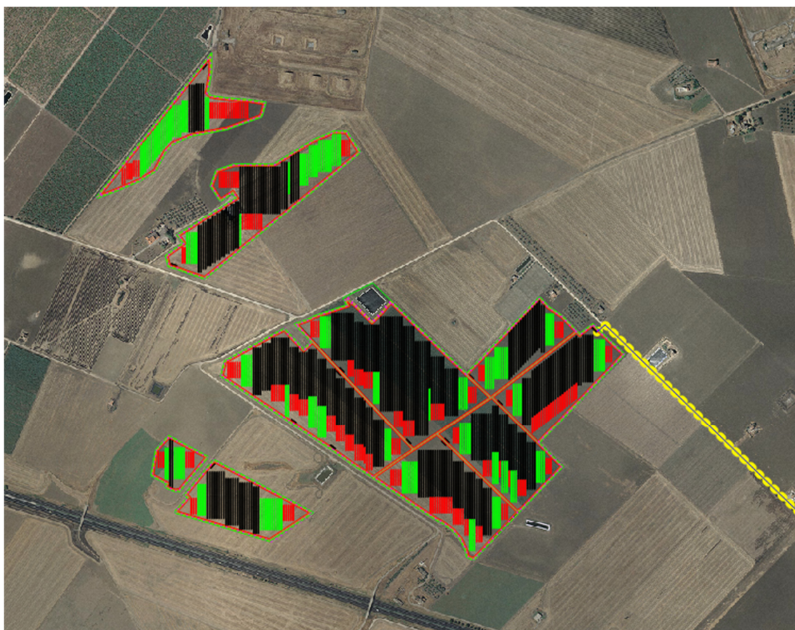
Figura 1-1 Impianto AGROSOLAR 3 su ortofoto
