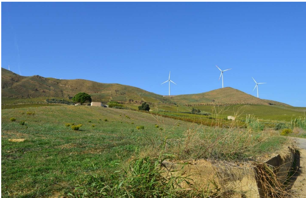
Figura 14 Documentazione fotografica Aree di impianto parco agrivoltaico
