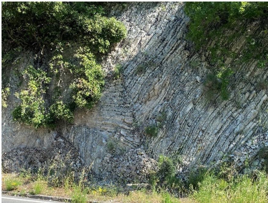
Figura 3.5 - Interventi di stabilizzazione dei versanti
