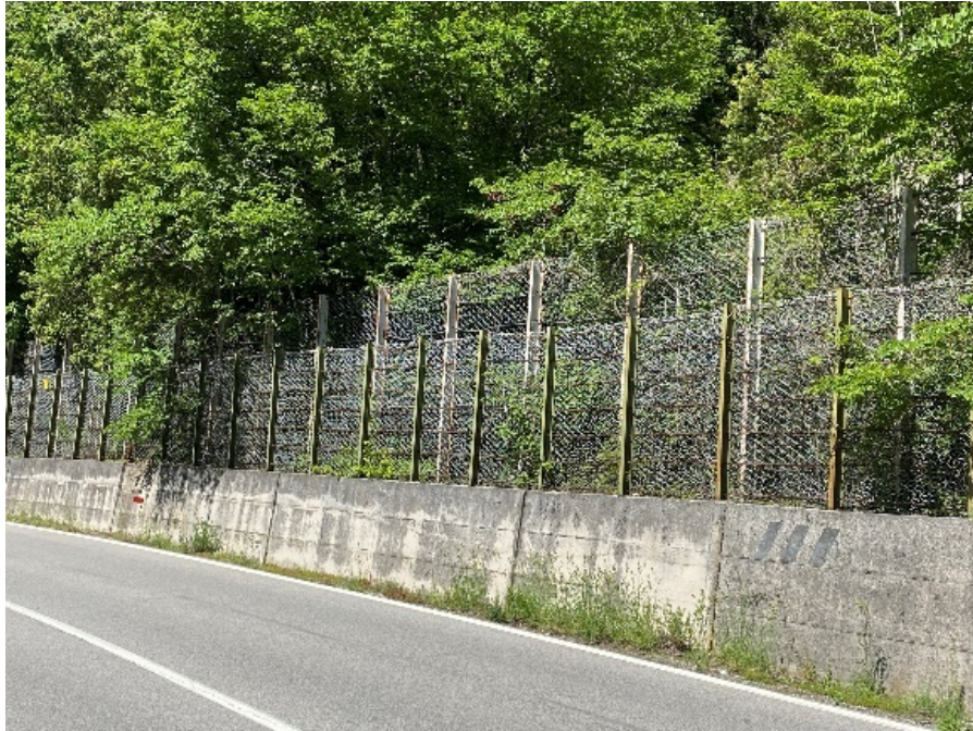
Figura 3.4 - Muri di controripa con rete paramassi
