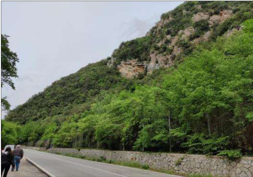
Figura 19 – Panoramica versante interessato dalla nuova galleria (lato Norcia)
