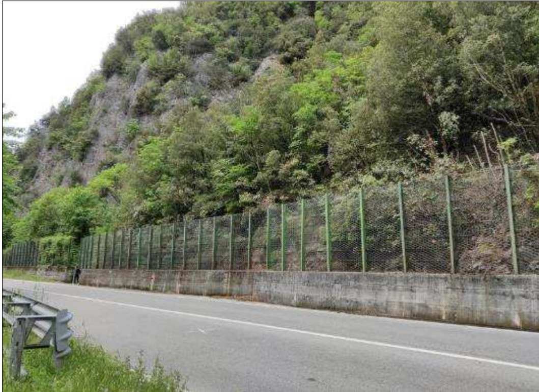
Figura 22 – Panoramica scarpata costituita dalla Scaglia rossa fittamente tettonizzata, interessata da interventi di consolidamento mediante reti e funi chiodate, pk 1+100 circa.
