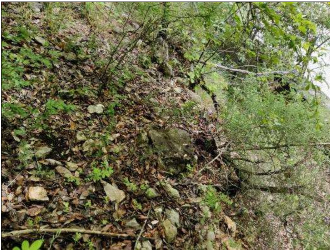
Figura 17 – Detrito con blocchi ciclici osservabili presso la pk 0+050
