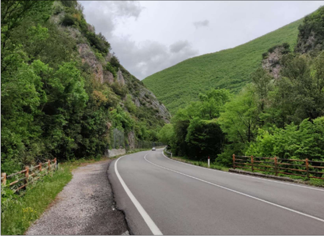
Figura 25 – Panoramica versante interessato dalla realizzazione di nuovo esteso muro di controripa (da pk 1+919 a p. 2+102)
