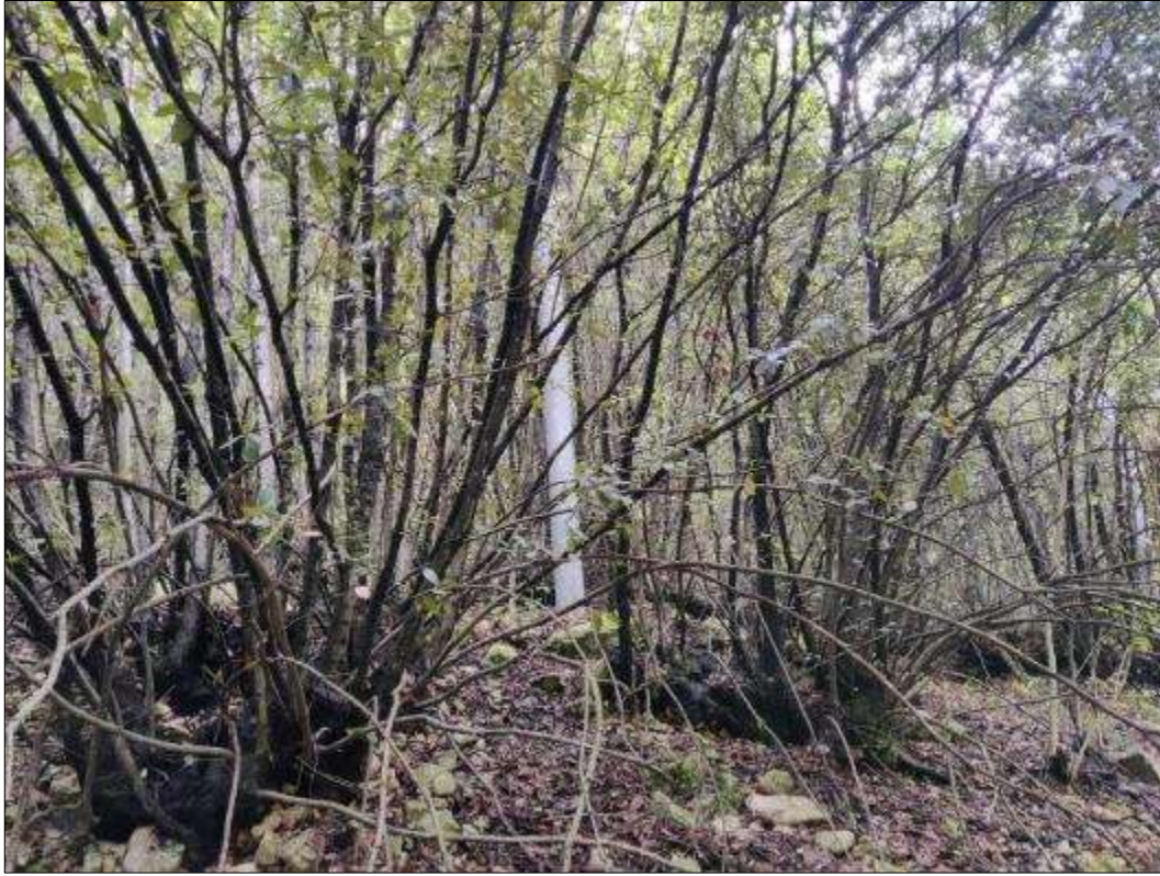
Figura 16 - Barriere paramassi in detrito alla pk 0+050
