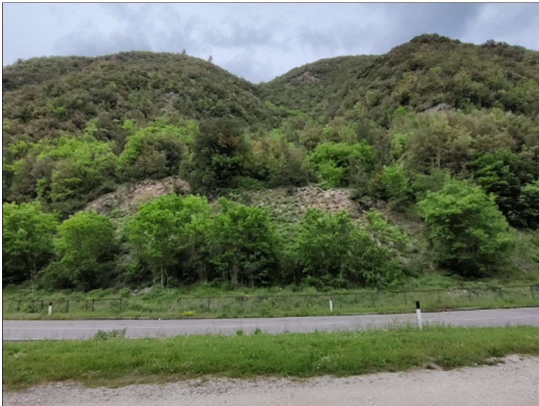
Figura 32 – Panoramica conoide centrata sulla pk 3+975.
