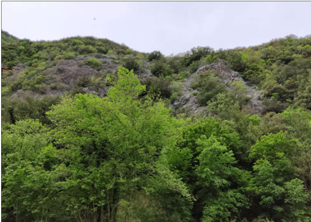
Figura 29 – Panoramica scarpata attualmente interessata da interventi di consolidamento mediante rete, funi e chiodature. Il progetto prevede riprofilatura e nuovi interventi di chiodatura (da pk 2+812 a pk 2+940).
