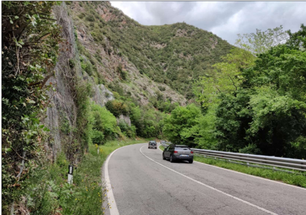
Figura 30– Panoramica, ripresa da pk 3+300 circa, dell'esteso versante roccioso interessato da fenomeni di crollo e fasce detritiche, che si estende dalla pk 3+300 a pk 3+650.
