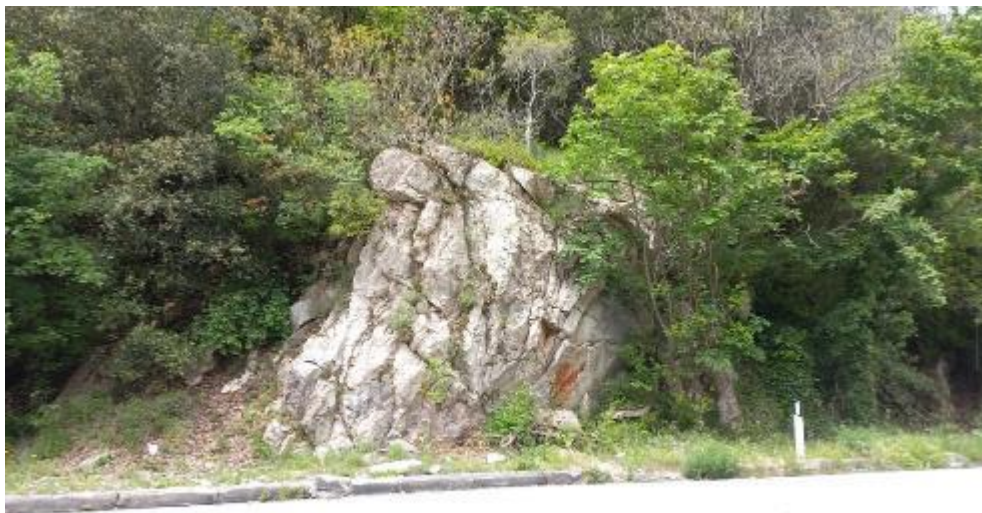
Stazione geomeccanica SG8
