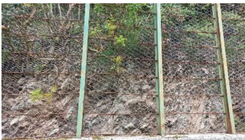
Stazione geomeccanica SG4
