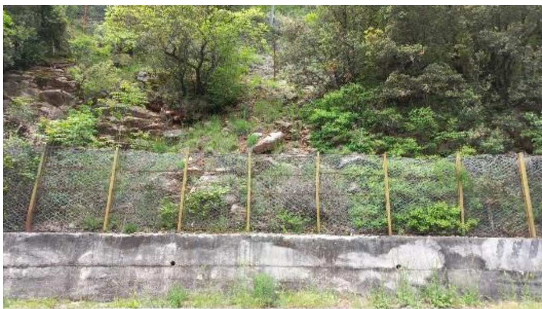
Stazione geomeccanica SG7
