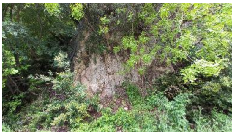
Stazione geomeccanica SG2
