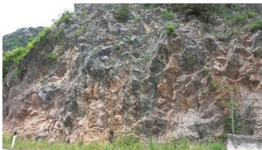
Stazione geomeccanica SG3
