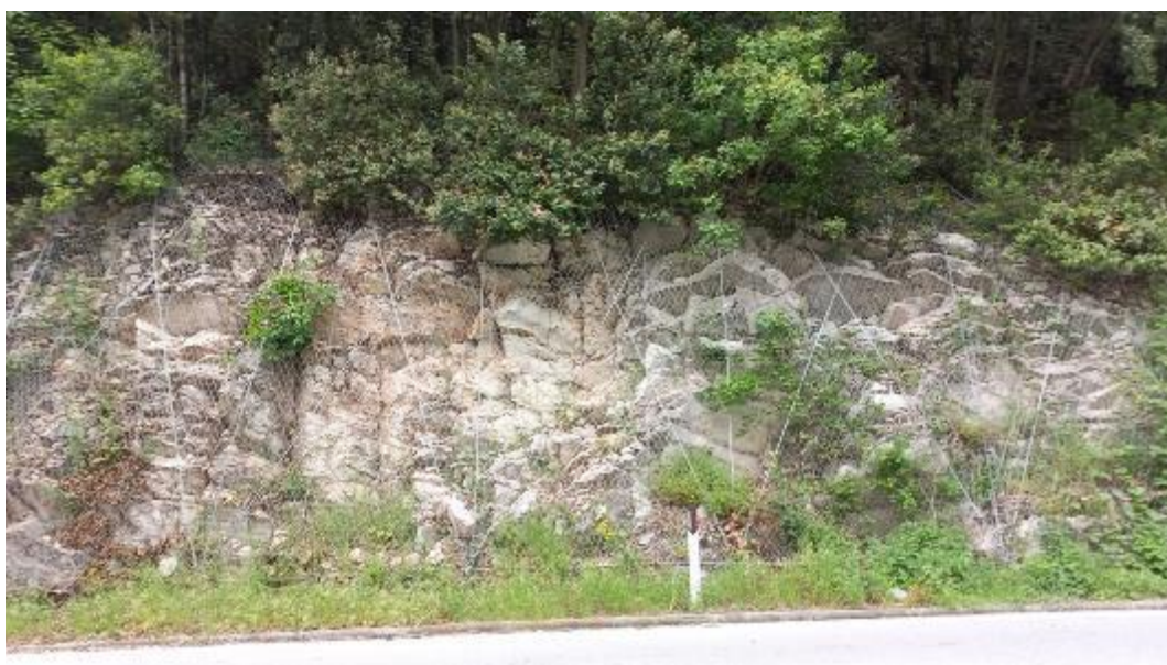
Stazione geomeccanica SG5
