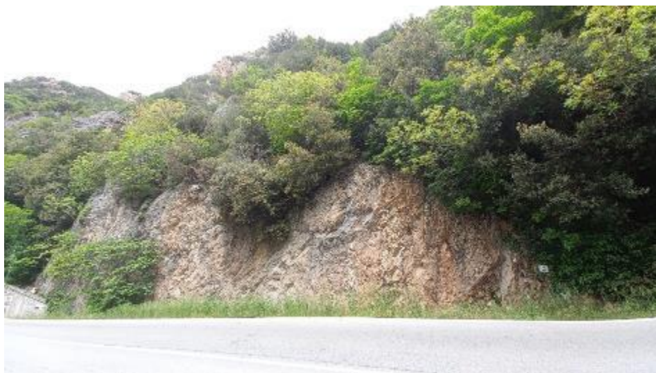
Stazione geomeccanica SG1
