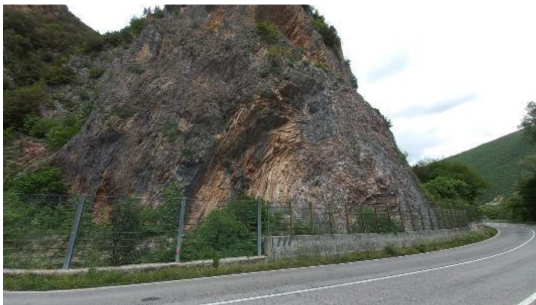
Stazione geomeccanica SG10
