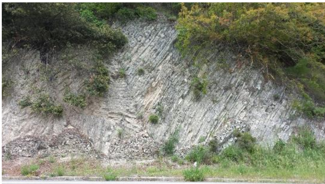
Stazione geomeccanica SG11
