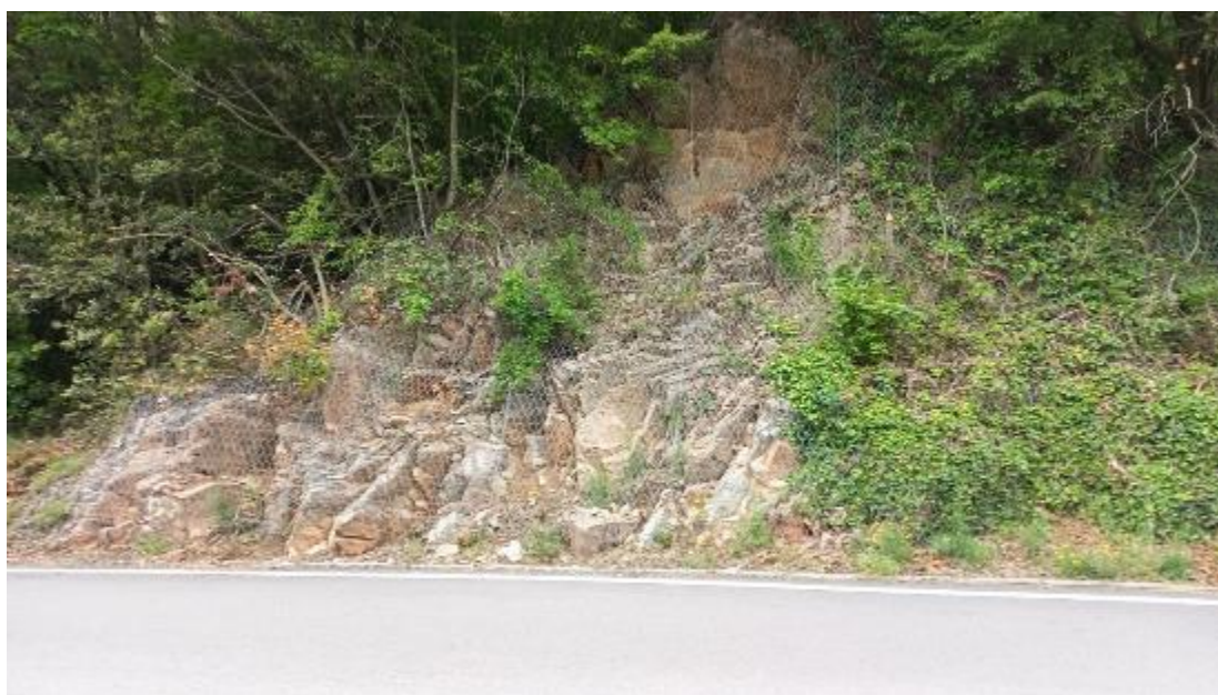
Stazione geomeccanica SG6
