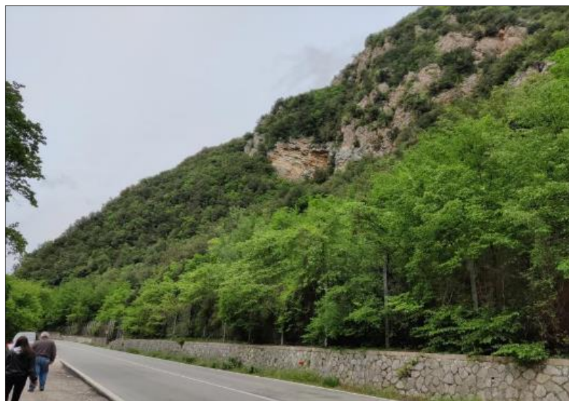
Figura 8 – Panoramica versante interessato dalla nuova galleria (lato Norcia)
