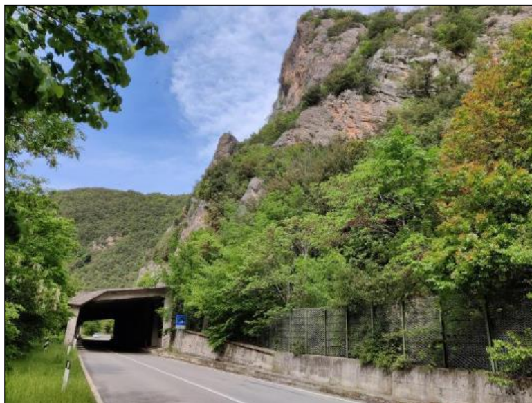
Figura 7 – Parete rocciosa costituita dalla Scaglia rossa (SAA) interessata dal crollo di blocchi lapidei e che ha comportato la realizzazione di protezione mediante costruzione di galleria artificiale.
