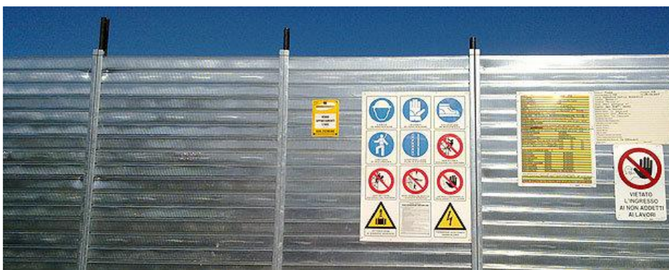
Figura 10.1 -Recinzione tipologica per delimitazione aree di cantiere
