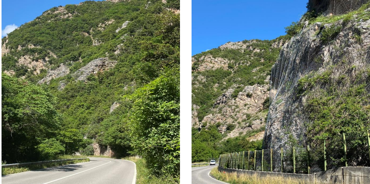
Figura 3.1: Foto stato di fatto
