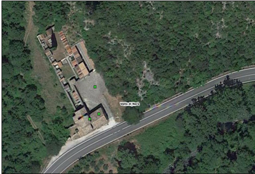
Figura 5.3: In verde il complesso della Chiesa di S.Maria dell’Eremita
