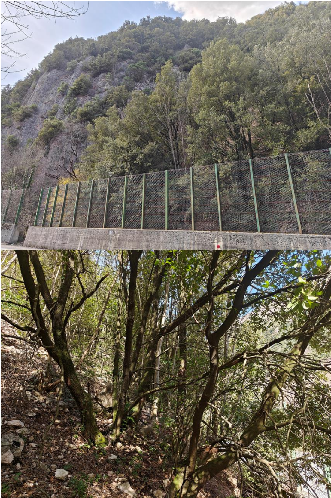
Figura 2–95: Esempio di alberature inserite per il dissesto dei versanti lungo la tratta in progetto
