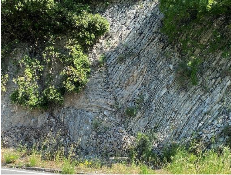
Figura 1–2: Interventi di stabilizzazione dei versanti
