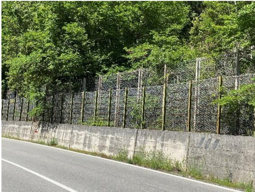
Figura 1–1: Muri di controripa con rete paramassi
