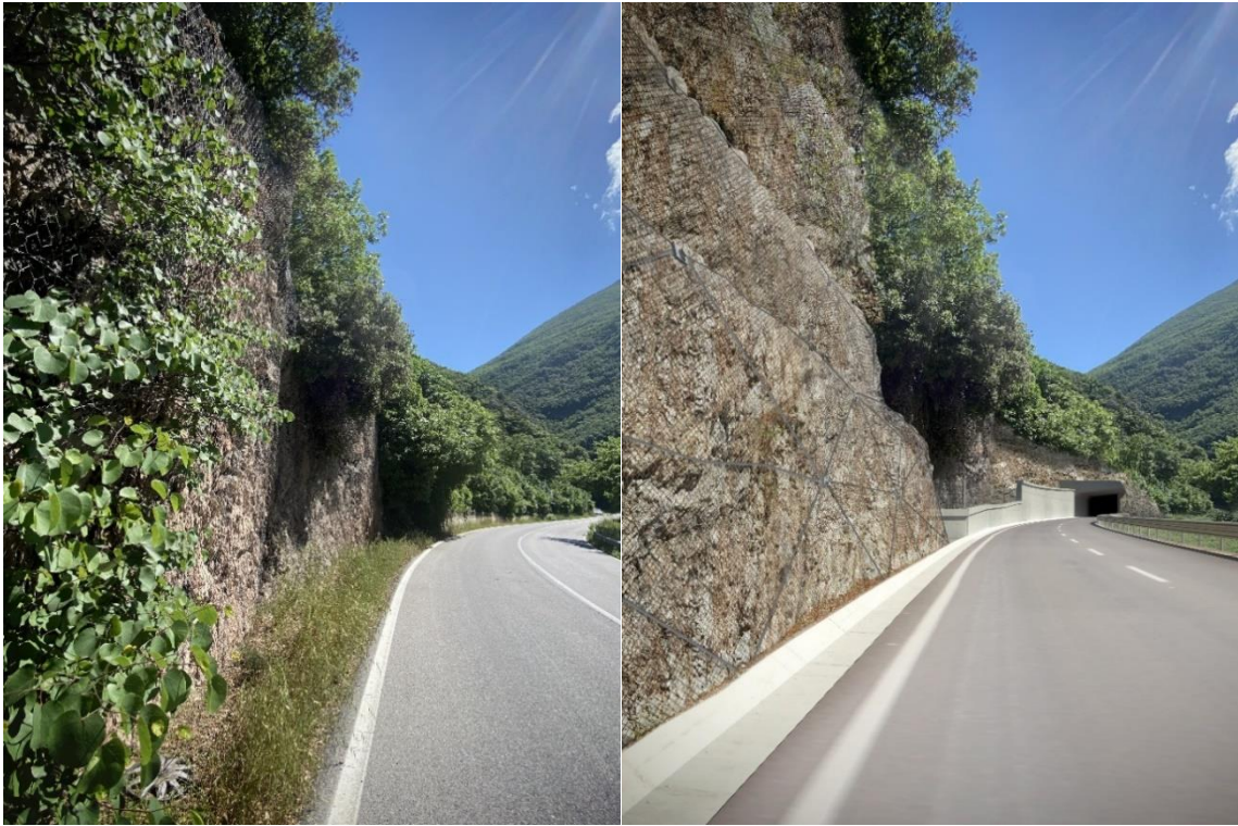
Figura 4-6 - Foto ante operam e post operam del Punto 1.
