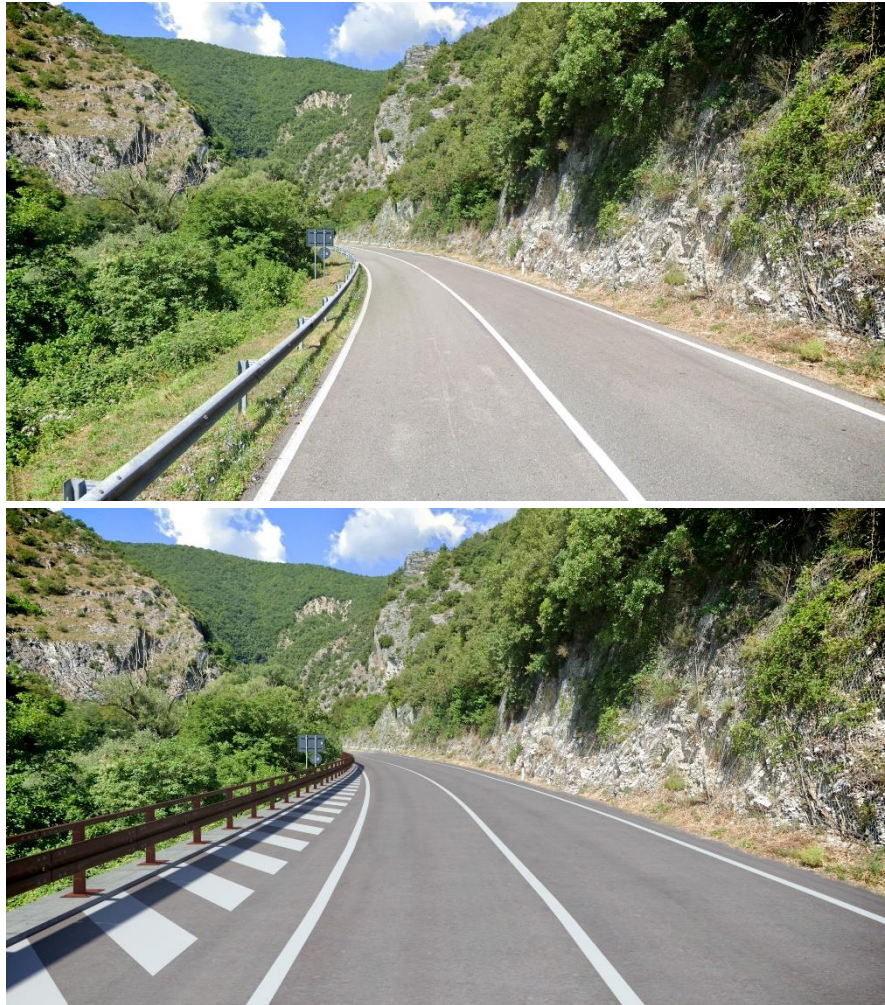
Figura 4-8 - Foto ante operam e post operam del Punto 3.
