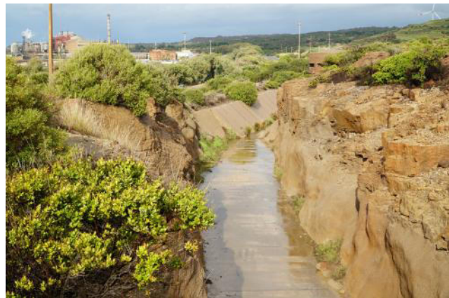
Foto 14 – Particolare di un tratto del Canale di Guardia (settore settentrionale).
