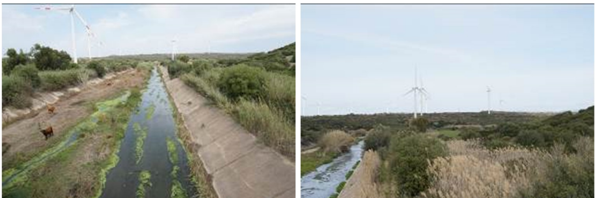
Figura 12: Canale di Paringianu : particolare del tratto terminale e vista panoramica del settore terminale.
