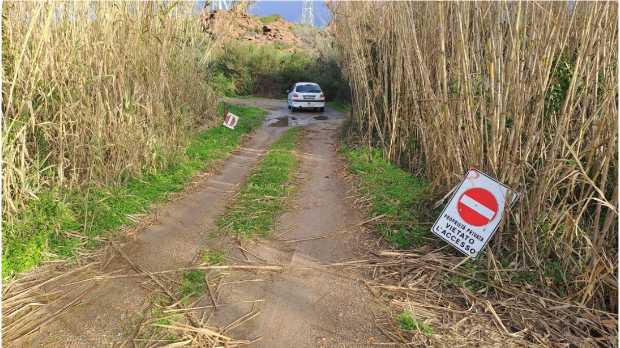
Figura 31: Stradello di penetrazione in corrispondenza dell'attraversamento del Riu Perdais .
