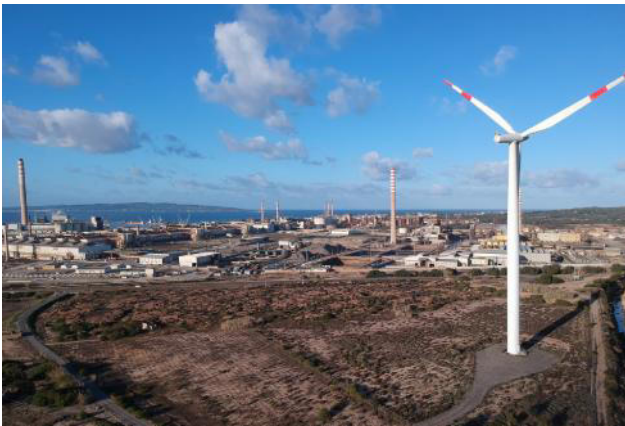
Foto 1 - Panoramica del settore a morfologia pianeggiante nei pressi del polo industriale di Portovesme.
