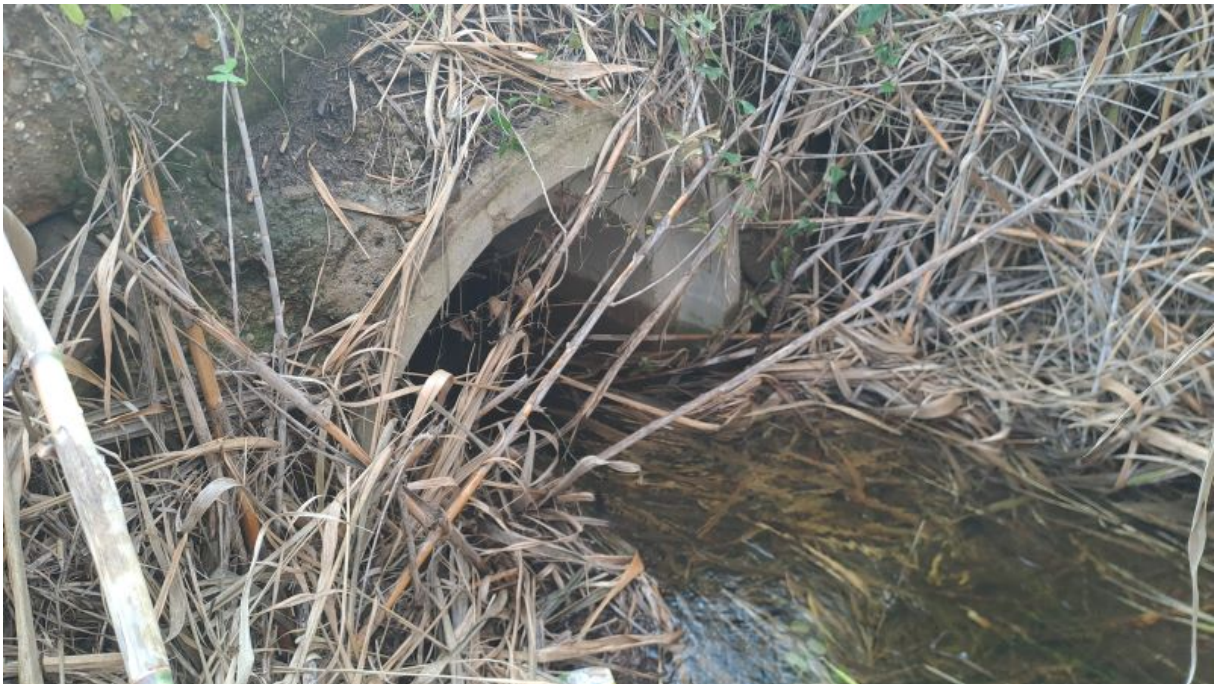
Figura 32: Particolare del manufatto di attraversamento del Riu Perdais .
